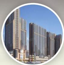
碧桂园中环荟项目供配电工程
