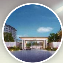
成发紫悦府变配电工程
