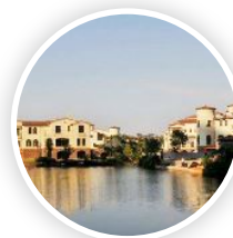
蓝光长岛国际社区二期 供配电工程
