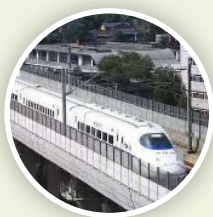
成蒲铁路西环线增建二线 10KV 电力线路迁改工程
