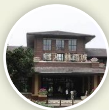
成都远大林语城南地块三期供配电工程
