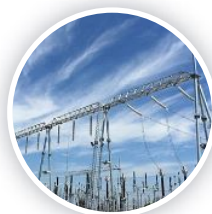
元豪电厂 220KV 开关站 新建工程施工项目
