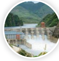
水电十局印尼丹巴托鲁 水电站项目
