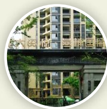
北大资源燕楠国际三期配电工程
