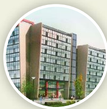
四川社会科学馆建设项目
