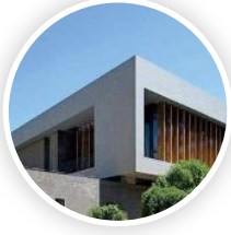
北京外国语大学配电 工程
